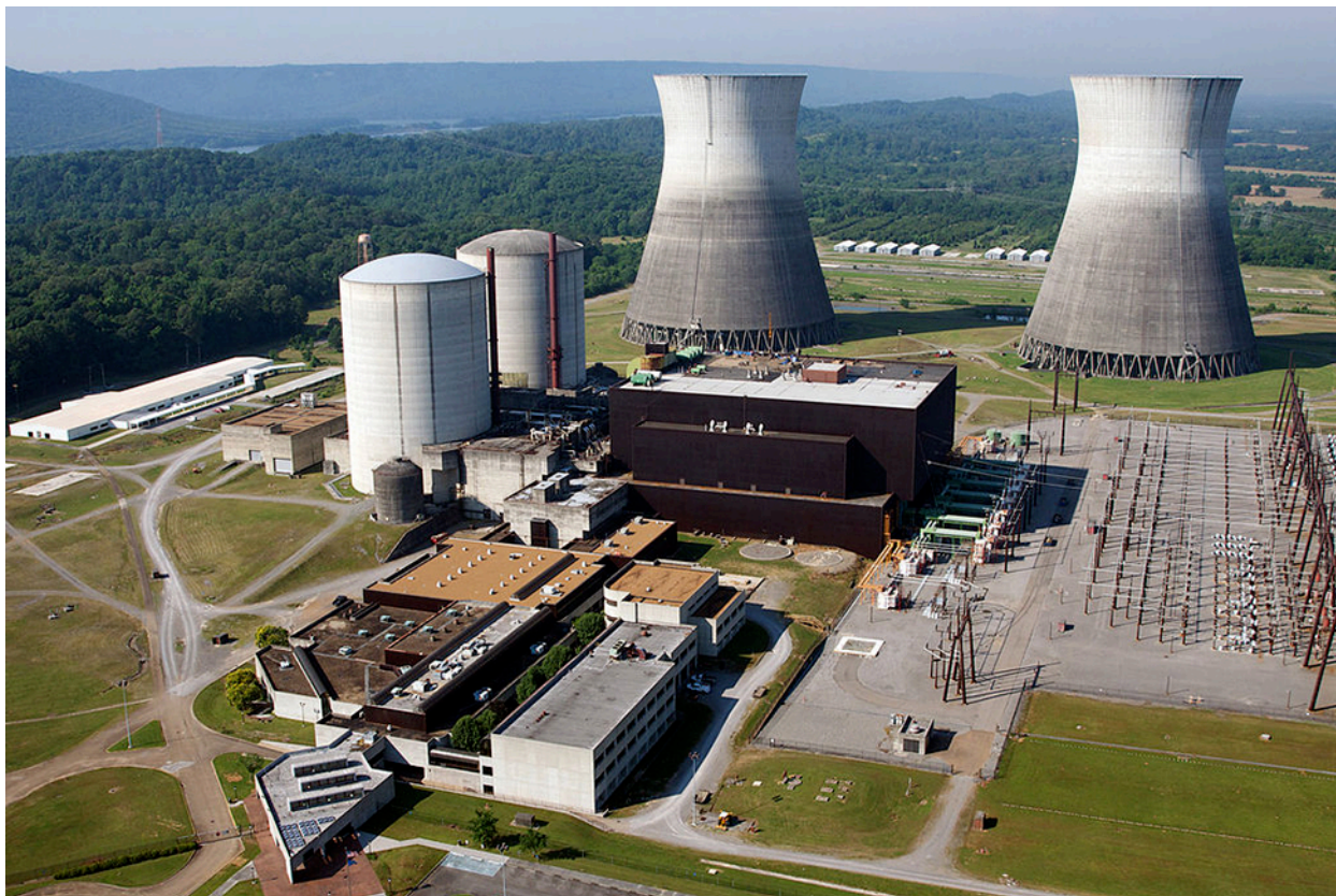
Rysunek 10.17 W reaktorach elektrowni jądrowej Philippsburg w Niemczech wytwarzana jest energia elektryczna.
