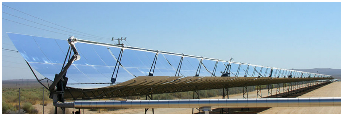
Rysunek 2.11 Paraboliczne zwierciadła wykorzystywane do generowania energii elektrycznej w południowej Kalifornii. Źródło: „kjkolb”/Wikimedia Commons
